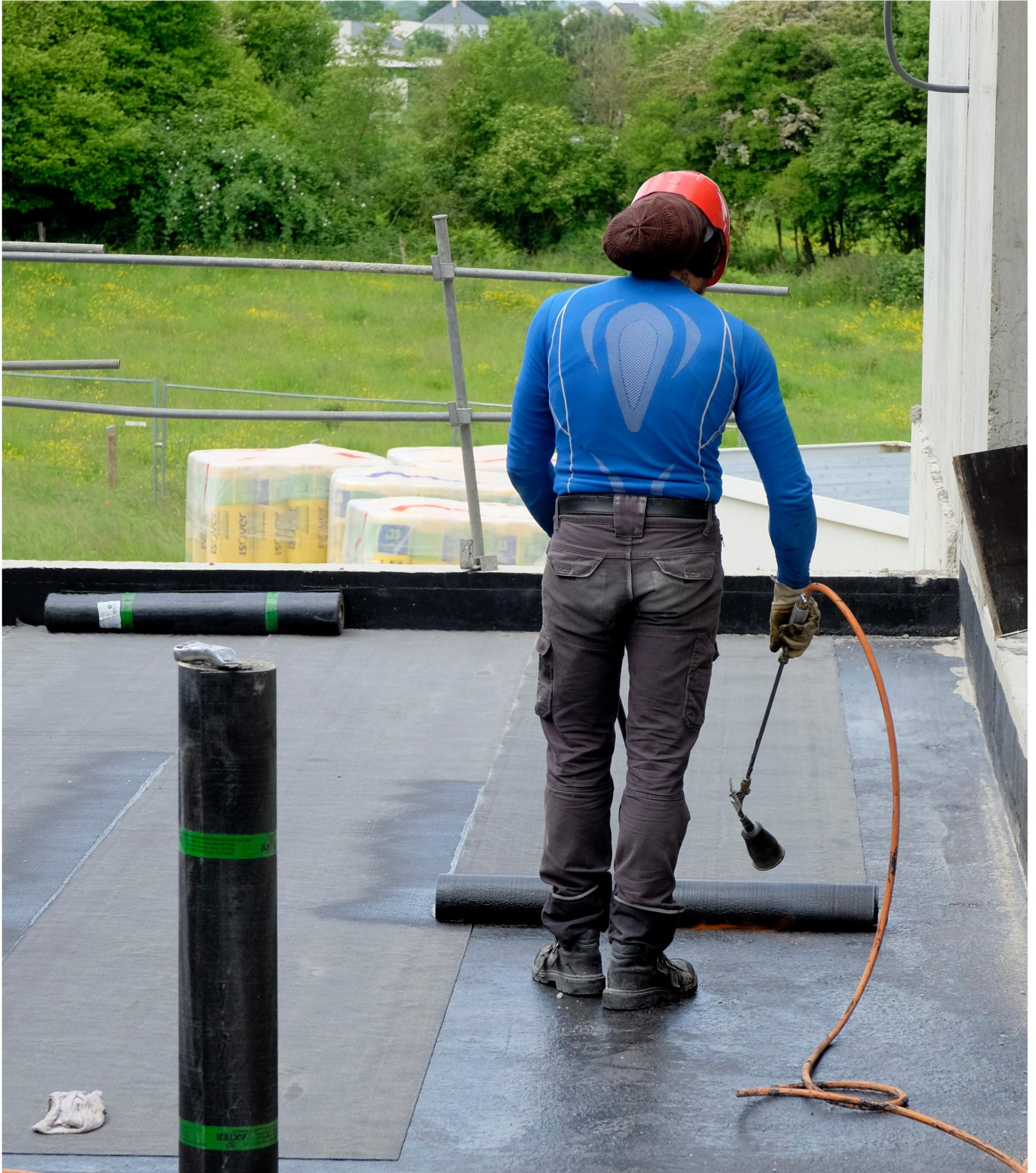
L'étanchéité toiture bâtiment réalise la mise hors d'eau de tous types de bâtiments, dans le cadre de travaux neufs ou de rénovation. Il prépare la sécurité collective, prépare les supports et met en œuvre les éléments d'étanchéité (enduit d'imprégnation, couches d'étanchéité, équerres de renfort, pare-vapeur, isolation, etc.), traite les points singuliers sur la toiture (évacuation des eaux pluviales, joints de dilatation, passe-câble, etc.), et réalise la protection de l'étanchéité réalisée.
