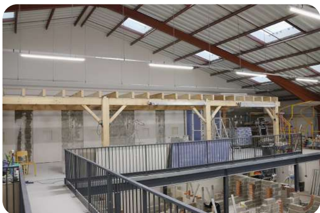
LA MEZZANINE GROS OEUVRE
