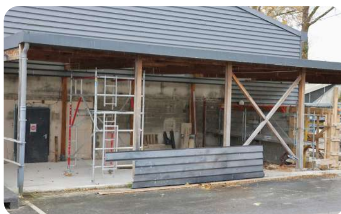
L'ATELIER COUVREUR (EN COURS DE CONSTRUCTION)
