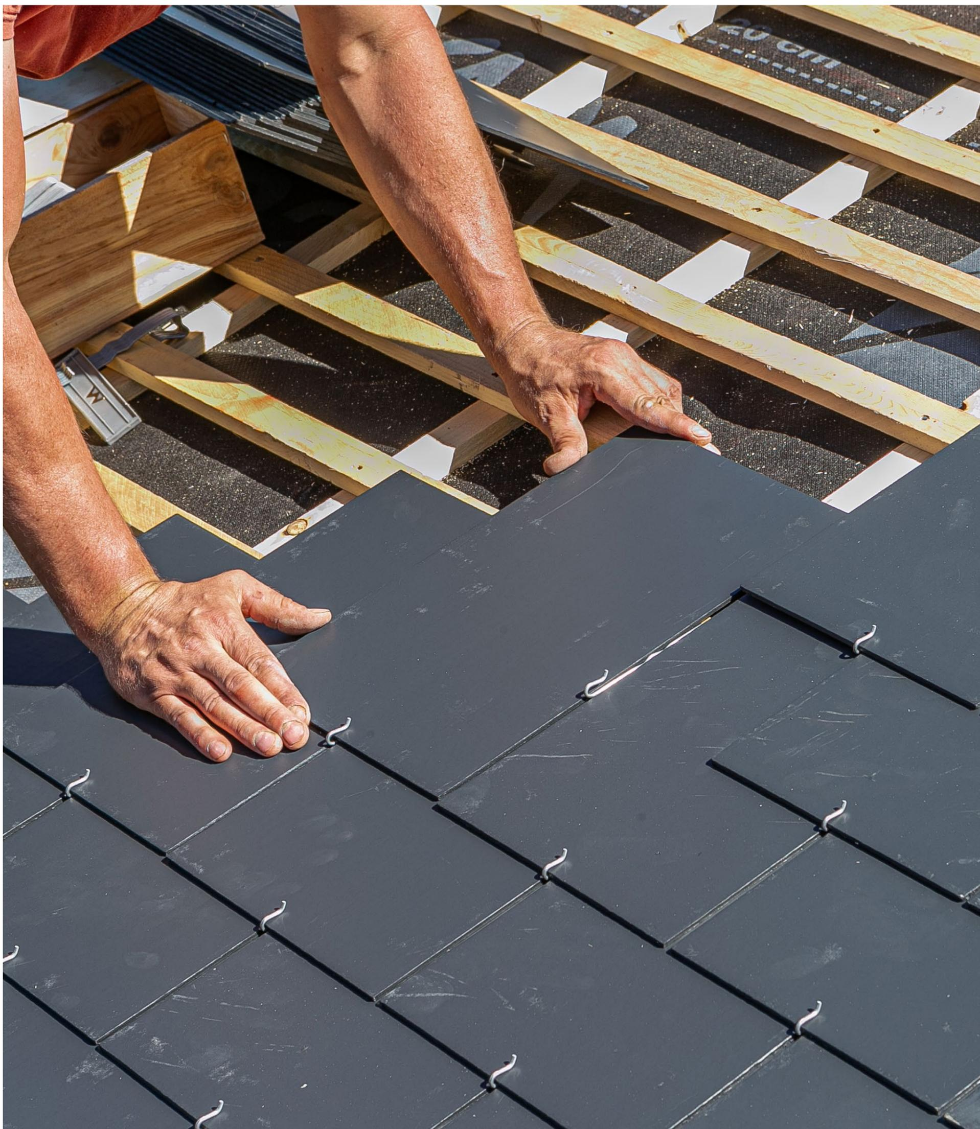
Le couvreur-zingueur réalise la mise hors d'eau de tous types de bâtiments, dans le cadre de travaux neufs ou de rénovation. Il prépare les supports et pose les éléments de couverture (ardoises, tuiles, tôles...), les protections des parties en saillie (rives, faîtages, arêtières, égouts), l'étanchéité autour des pénétrations (cheminées, murs, panneaux solaires thermiques et photovoltaïques, fenêtres de toit...) et les systèmes d'évacuation d'eaux pluviales (gouttières et tuyaux de descente).
